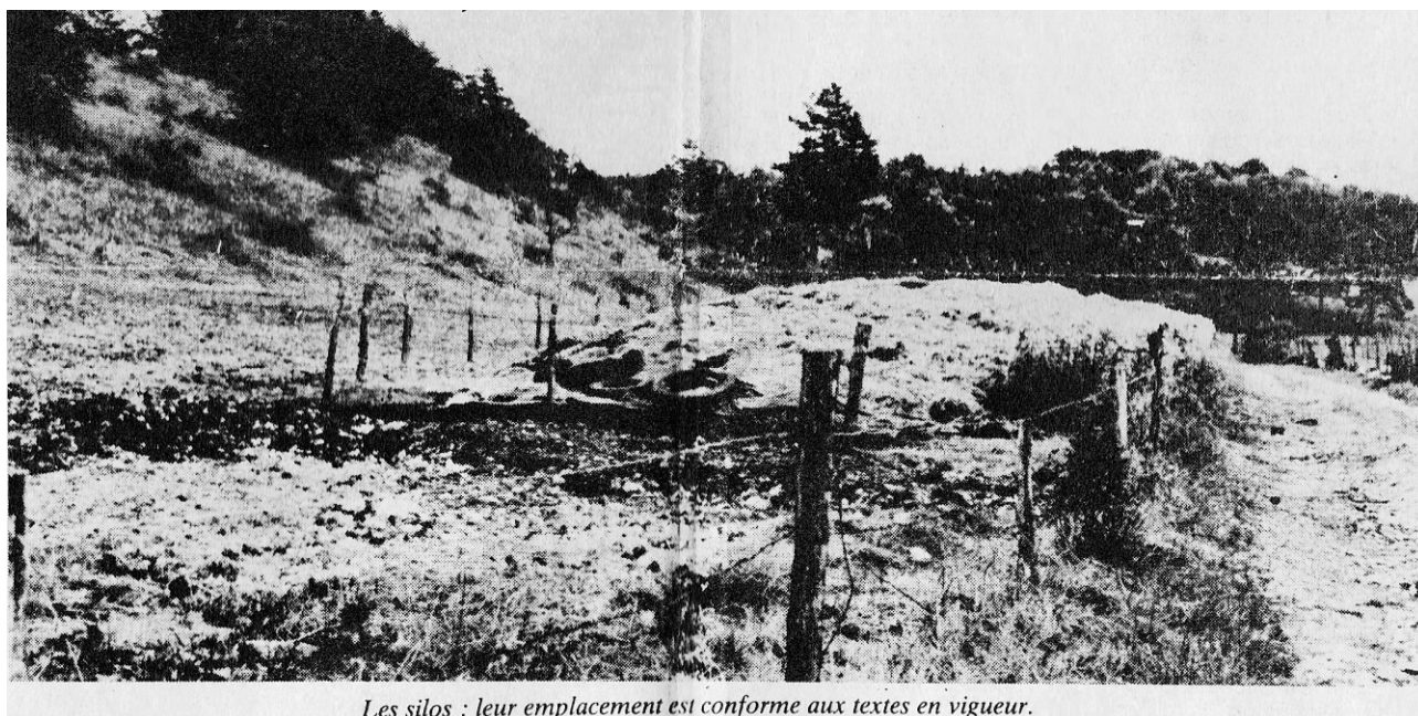
Les silos : leur emplacement est conforme aux textes en vigueur.
